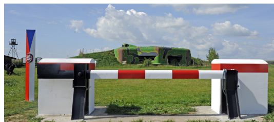
3) Pěchotní srub MJ – S 3 / Šatov
