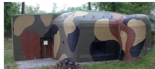
10) Lehký objekt ŘOP / Dyjávovice
