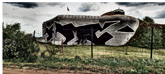
4) Pěchotní srub MJ – S 4 / Chvalovice
